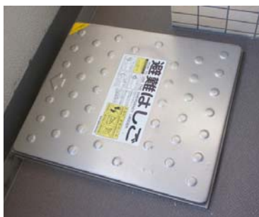
共用部分のバルコニー。区分所有権を持つ購入者には、専用使用権が。ただ火災などの非常時には他の住民も使用できることになっています。
