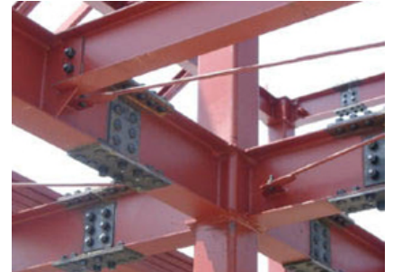
鉄骨造に使用する代表的な鋼材。断面がアルファベットのHの形をしているのでH鋼と言います。
